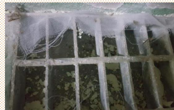
▲地下室排水道增設紗網，不僅可預防排水道淤積，也能杜絕成蟲飛出。
